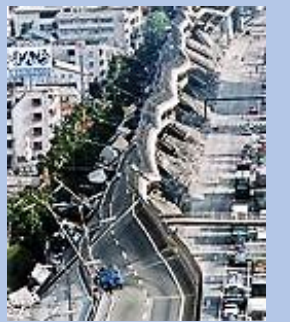
「倒壊した阪神高速道路」
