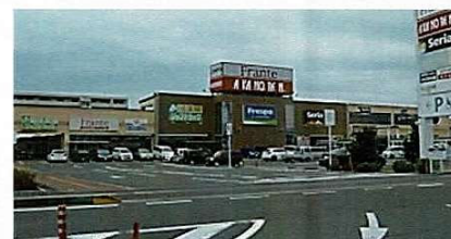
プレスボ四日市富田屋上駐車場
