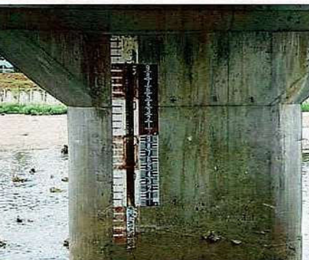
「朝明橋、橋脚に水位目盛り表示」
