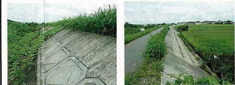
「表側(河川側)法面」
