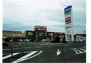
(津波避難ビル：プレスポ四日市富田店)
